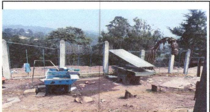
Foto 4: Circulación en mal estado, malla rota y tubo doblado.
