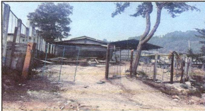
Foto 3: Porton en mal estado, malla rota y columnas de madera deterioradas.
