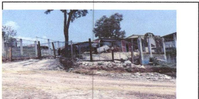
Foto 6: Circulación en mal estado, malla rota y columnas quebradas.
